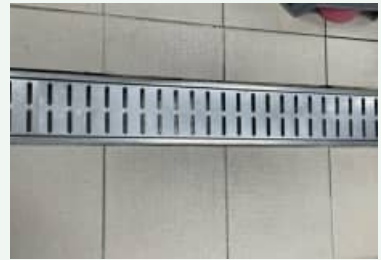
트렌치 설치 및 바닥 청결관리
