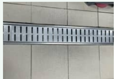
트렌치 설치 및 바닥 청결관리
