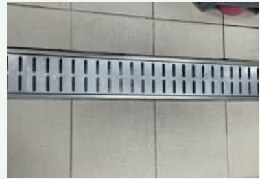
트렌치 설치 및 바닥 청결관리
