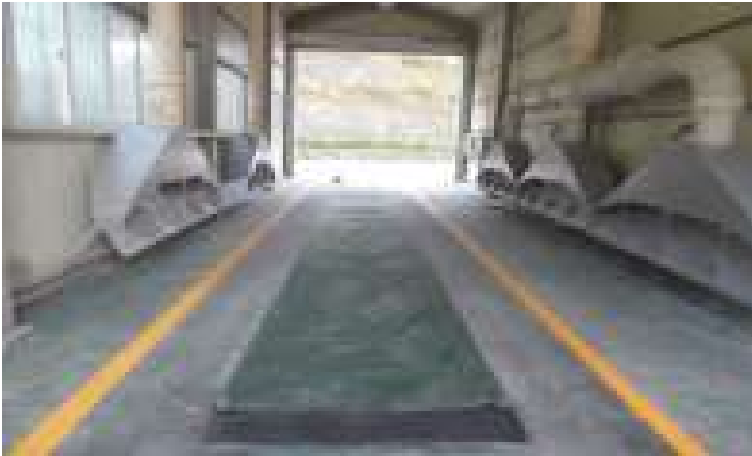
<주원료 투입구 집진시설 및 덮개 설치>
